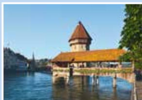
Kappelbrücke, Kanton Luzern
